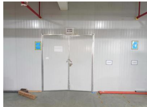
汽车零部件厂区危化品仓库
