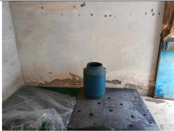
工程塑料厂区危废仓库
